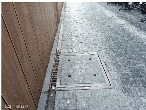
บ่อ Man Hole ที่ใช้เป็นระบบบ่อหน่วงน้ำ ภายในโครงการ
